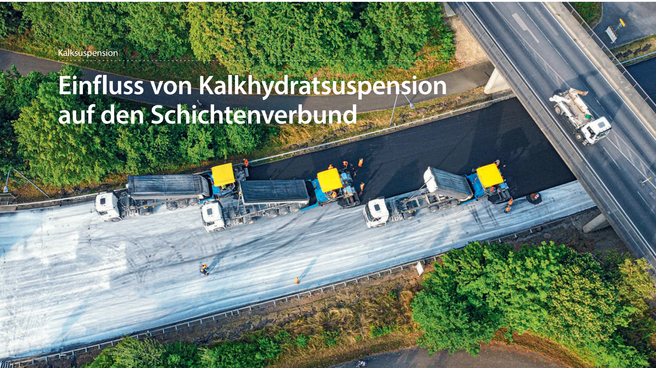
Bild 1: Aufbringen der Kalkmilch mit Spritzrampe [9]. (Quelle: Nadler)
